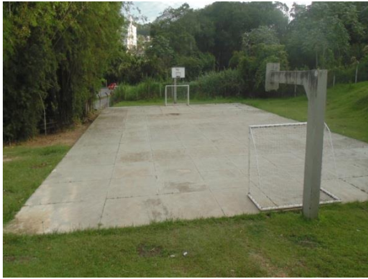
Figura 13 - Quadra de concreto
