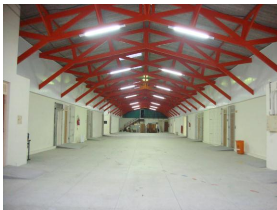
Foto 2: Galpão – espaço coberto.
